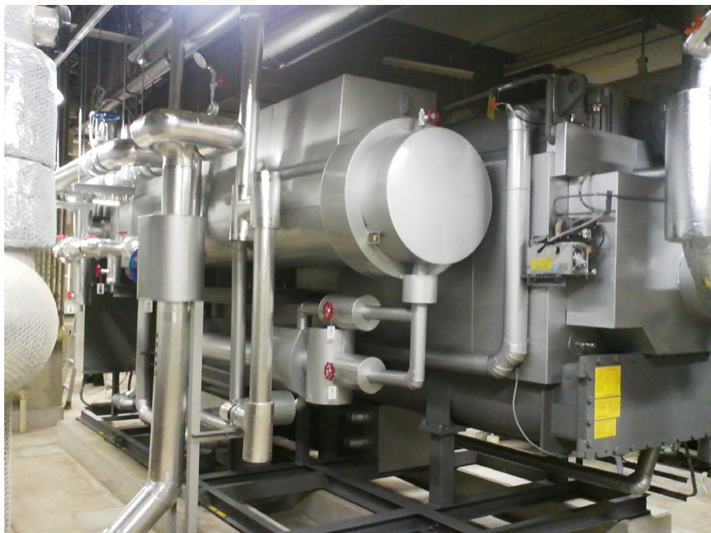
総合リハビリテーションセンターA 棟冷凍機改修工事
