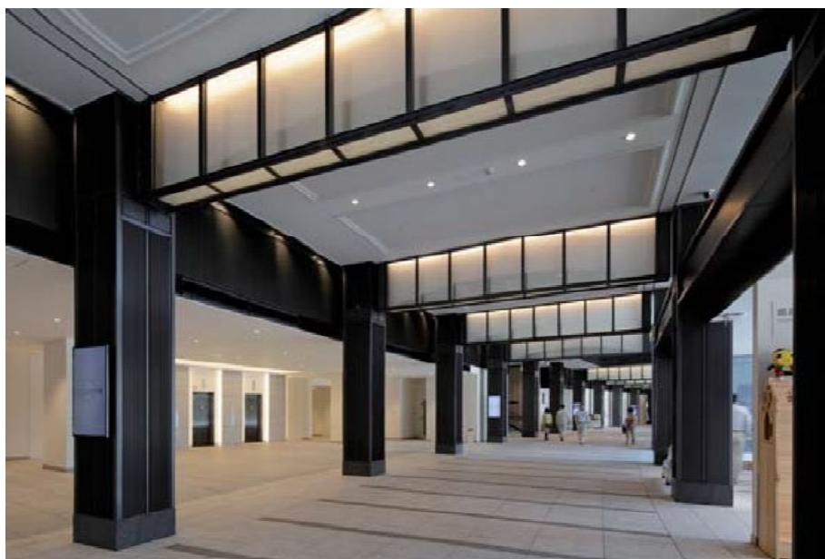
西部地域振興ふれあい拠点施設ウエスタ川越給排水衛生設備工事
