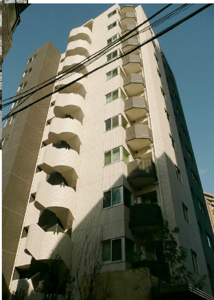
ライオンマンション戸田公園A棟B棟新築工事
