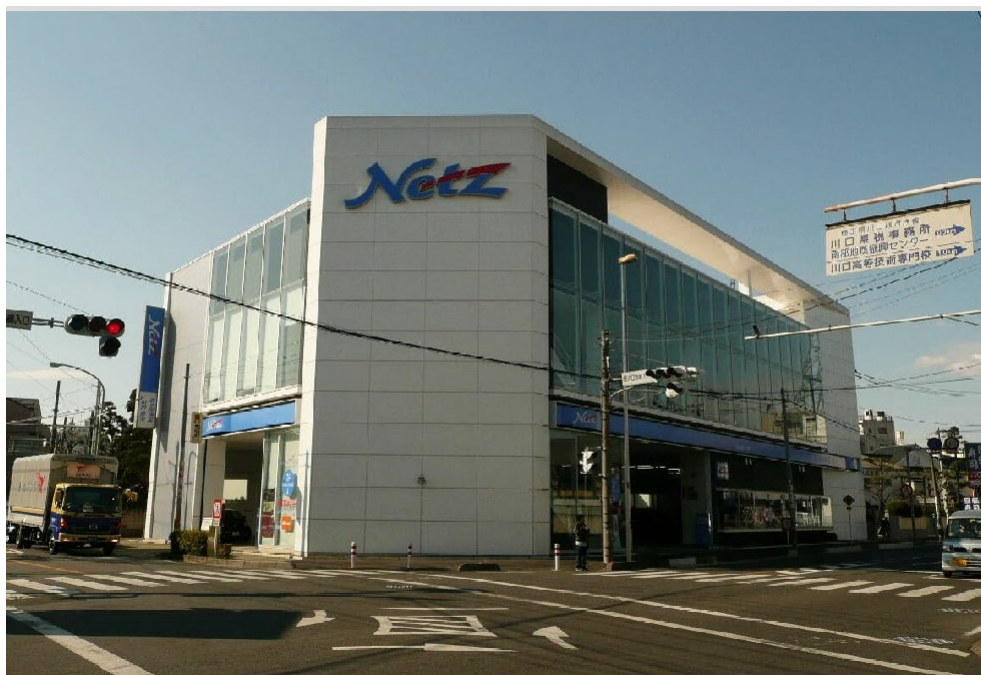
安藤第1ビル新築工事
