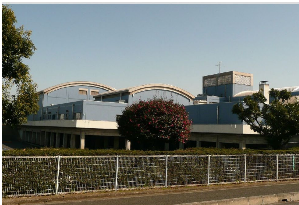
障害者交流センター新築（機械設備）工事
