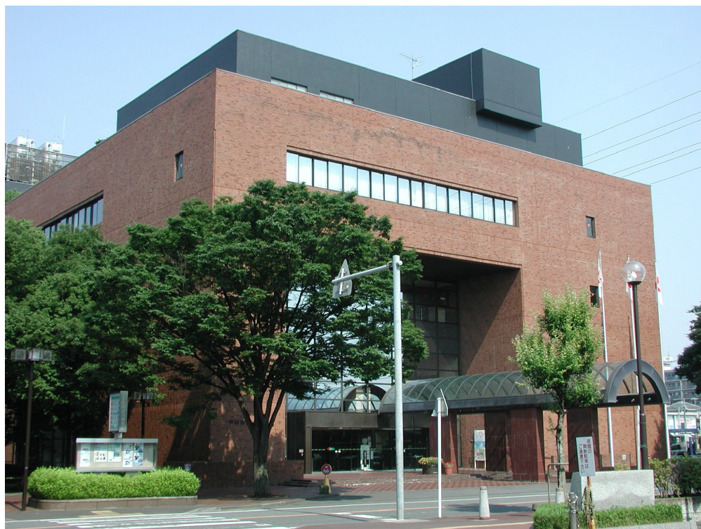
戸田市文化会館冷温水機改修工事
