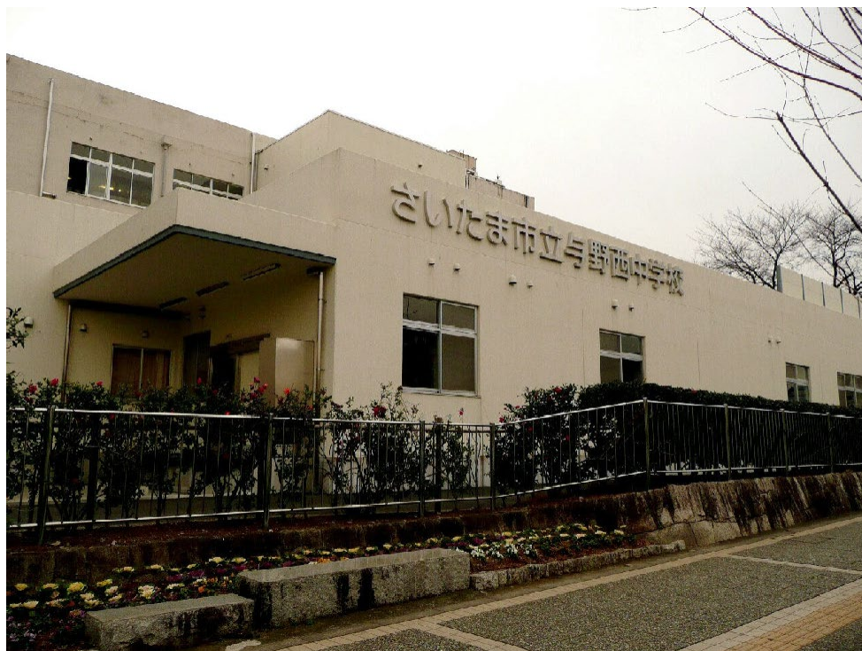
与野西中学校給食室建設（機械設備）工事
