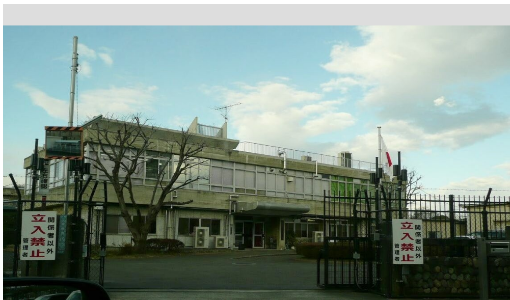
埼玉県警察本部分庁舎(木崎)改修工事
