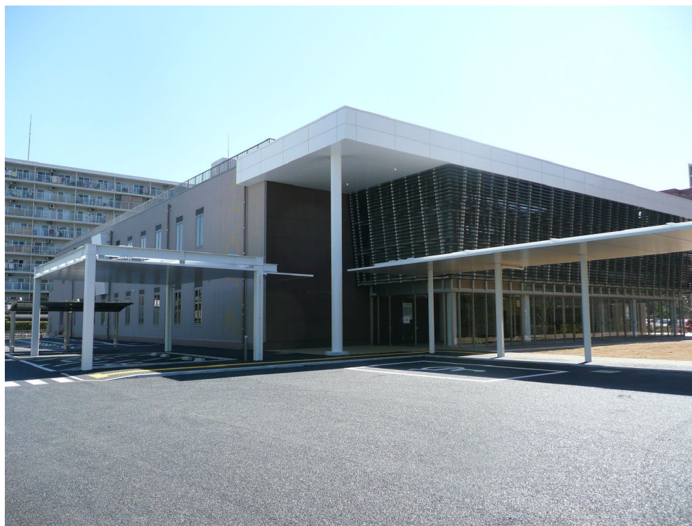
戸田市福祉保健センター新築工事
