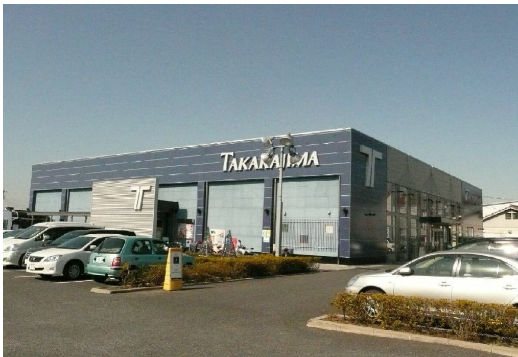
宝島越谷2号店新築(空調設備)工事
