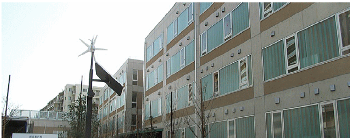
さいたま市立つばさ小学校給食室・プール棟新築（機械設備）工事
