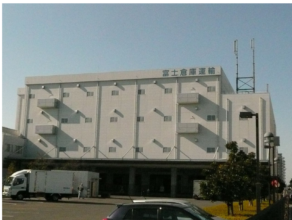
富士倉庫運輸空調設備工事
