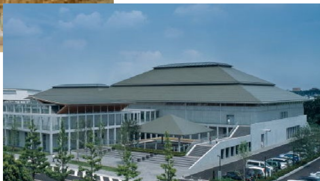
埼玉県立武道館新築工事（給排水・衛生）工事
